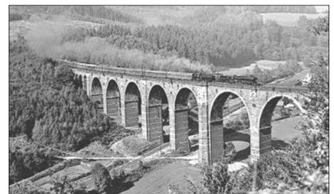
*In der Dampflok-Zeit (Aufnahme von 1978) die normale Situation beim Blick von der Hetzdorfer Bastei auf den Hetzdorfer Viadukt: Im Vorspann- bzw. Nachschiebedienst werden Personen- und Güterzüge von Dampflokomotiven auf der Steilrampe zwischen den Bahnhöfen Flöha und Oederan mit 131 Metern Höhenunterschied gezogen bzw. abgebremst.*
