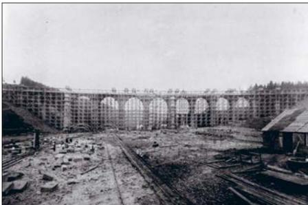
Die Bauarbeiten am Hetzdorfer Viadukt sind in den Jahren 1867 und 1868 im vollen Gange. Im Vordergrund die Transportbahn vom Bahnhof Flöha.
