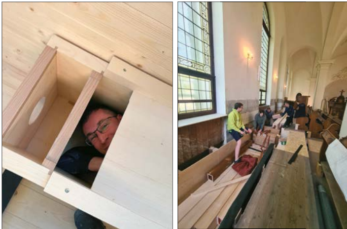
Schier unvorstellbare Dimensionen: Mitarbeiter der Brandenburgischen Orgelbauwerkstatt Jona Baaske von der Orgelbauwerkstatt Schuke beim Einbau der Schuke bei der Feinjustierung mitten Basspfeifen unter die Emporensitzbänke in einer 64 Fuss Pfeife des Gehörlosenregisters (v.l. Constantin Möller, Janik Gierloff, Malte Kaempf und Jona Baaske) Fotos: Matthias Moser
