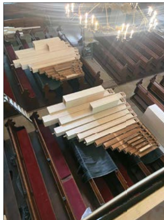
Fein säuberlich sortiert und zum Einbau bereit: Die 31 Pfeifen des Gehörlosen- kg schwere 64 Fuss Pfeife auf ihrem Weg registers und die 12 Pfeifen des Vulkan- auf die Empore: Eine logistische Meister- bass-allesamt werden unter den Empo- leistung der Orgelbaufirma Schuke renstzibänken verbaut
