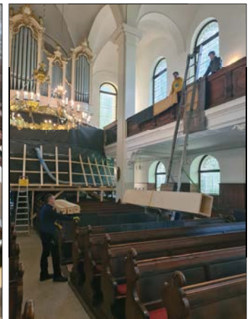
Fein säuberlich sortiert und zum Einbau bereit: Die 31 Pfeifen des Gehörlosen- kg schwere 64 Fuss Pfeife auf ihrem Weg registers und die 12 Pfeifen des Vulkan- auf die Empore: Eine logistische Meister- bass-allesamt werden unter den Empo- leistung der Orgelbaufirma Schuke renstzibänken verbaut
