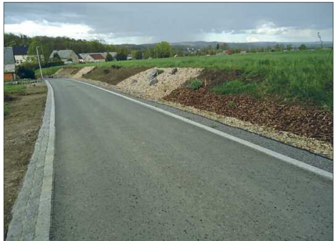
Die Straßenrandbereiche werden z.T. durch die Anlieger selbst hergerichtet. Fotos: Stadtbauamt
