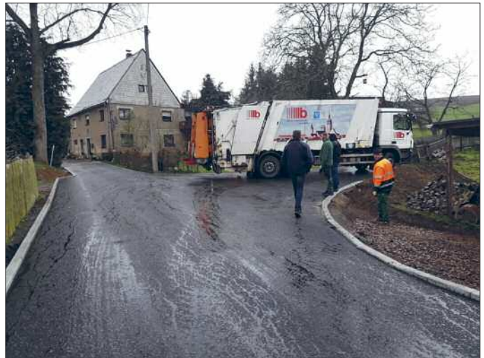
Endlich können Fahrzeuge der Ver- und Entsorgung an den Straßenenden ordnungsgemäß wenden
