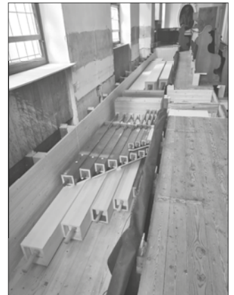
Die Pfeifen des Vulkanbasses unter den damals noch nicht geschlossenen Emporenbänken. Der Besucher sitzt faktisch auf den Basspfeifen (Foto Moser)
