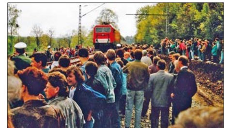
Der 12. Mai 1992 - ein großer Tag für die Region. Der Eröffnungs-Sonderzug steht genau an der Stelle zur Abfahrt bereit, wo sich zuvor die Blockstelle Hetzdorf befand, die der Neubaustrecke weichen musste. Foto: Archiv Interessenverein Hetzdorfer Viadukt
