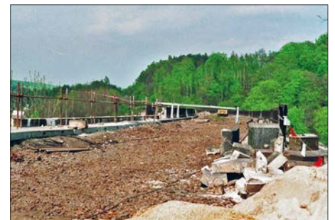
Der Zustand auf der Krone des Hetzdorfer Viadukts nach Abbau der Oberleitungsanlagen und der Gleise. Große Teile der Brüstung waren abgebrochen, der Schotter noch nicht beseitigt. Foto: S. Deichsel
