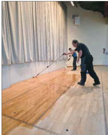
Mitarbeiter der Firma Kleditzsch bei der Arbeit
