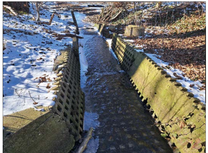
Ein mit Rasengittersteinen verbautes Gewässer. Die Platten sind instabil und im Hintergrund kann man sehen, wie sie bereits ins Gewässer fallen. Zurück bleibt ein ungeschütztes Ufer.
