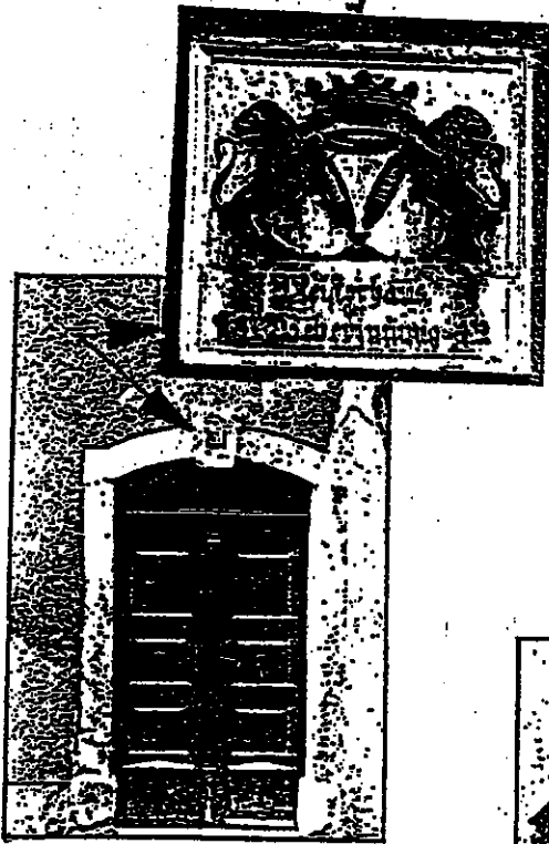
Webermeisterhaus Enge Casse 6
