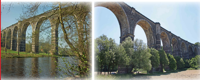
Der Hetzdorfer Viadukt - Eisenbahnromantik auf zwei Ebenen im Flöhatal einst und reizvoller Wanderweg über die historische Brücke heute
