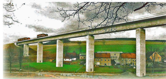
Titelseite einer Broschüre der Deutschen Reichsbahn aus Anlass der Fertigstellung des Neubauabschnitts Hetzdorf der Sachsenmagistrale Görlitz-Plauen. Unten im Bild die Probelastung der neuen Spannbetonbrücke 1 über den Hetzbach.
