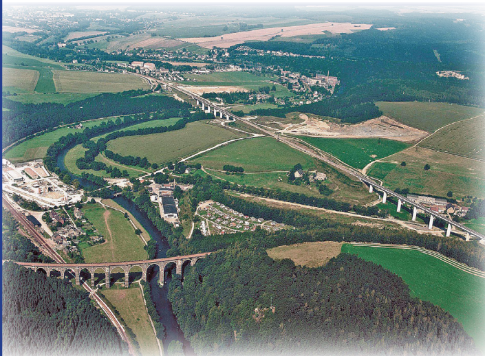
Blick auf die Neubaustrecke mit ihren zwei modernen Stahlbetonbrücken (im Bild rechts) in der Bauphase. Im Vordergrund links der Hetzdorfer Viadukt und die damaligen Baustelleneinrichtungen. Außerdem im Bild: Die Strecke der Erzgebirgsbahn von Chemnitz über Flöha nach Olbernhau-Grünthal bzw. Marienberg über Pockau-Lengefeld.
