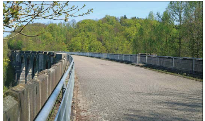
Der Zustand auf dem Viadukt seit dem Jahr 2000. Gut erkennbar das Sicherungsgeländer und das Pflaster aus Betonformsteinen. Dieses wurde im Herbst 2018 durch einen Asphaltbelag ersetzt.
