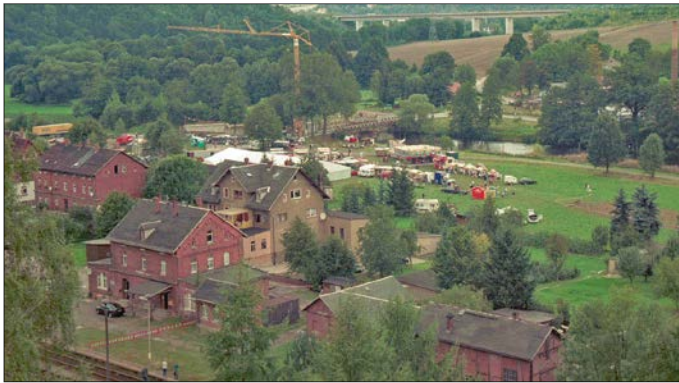
Blick auf den Veranstaltungsort des Brückenfestes 1999, aufgenommen vom Viadukt. Im Vordergrund der Bahnhof Hetzdorf/Flöhatal, Kreuzungsbahnhof der Erzgebirgsbahn zwischen Chemnitz und Olbernhau. Der Kran im Hintergrund zeigt, dass damals der Neubau der Straßenbrücke über die Flöha im vollen Gang war.
